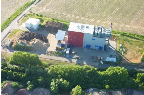
Biomasseheizkraftwerk als Bestandteil des virtuellen Kraftwerks der Gemeindewerke Enkenbach-Alsenborn
